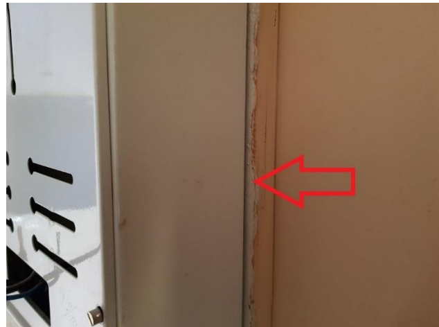
Kuvat 3 -6. Sähkökeskuksien takana paloeristeenä asbestipitoinen sementtipohjainen pahvi.
