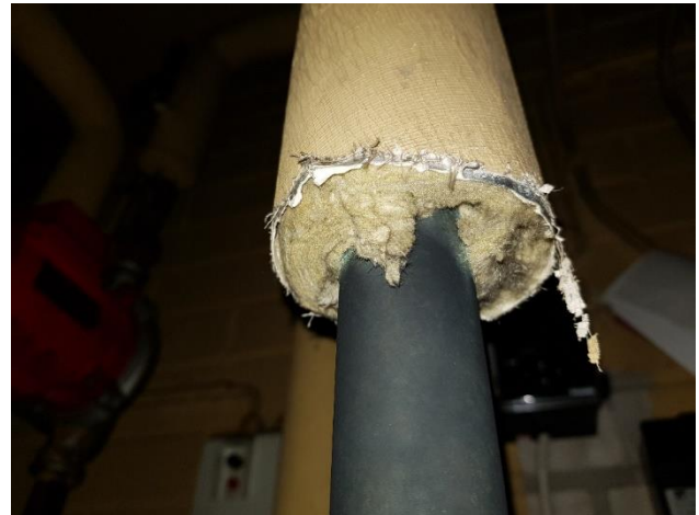
Kuvat 7 – 10. Lämmönjakuhuoneen putkieristeiden pintakangas sisältää asbestia.
