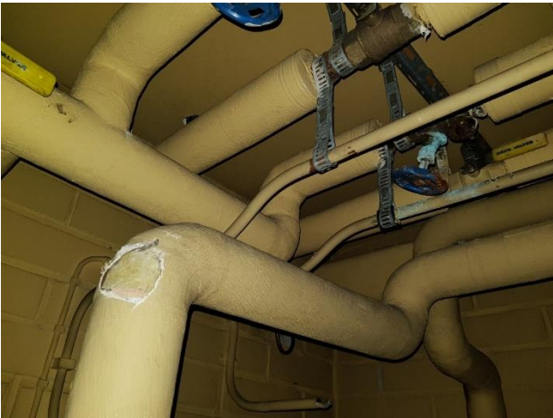
Kuvat 7 – 10. Lämmönjakuhuoneen putkieristeiden pintakangas sisältää asbestia.
