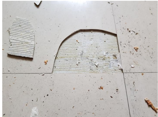
Kuvat 1 ja 2. Kerhotilan asbestipitoiset vinyylilaatat kiinnitetty asbestittomalla dispersioliimalla.
