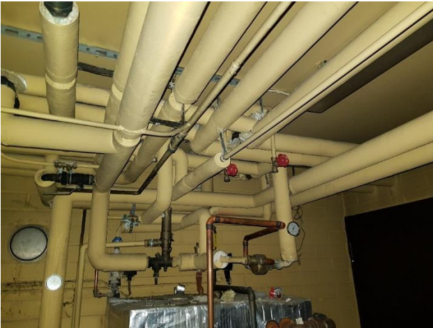
Kuvat 7 – 10. Lämmönjakuhuoneen putkieristeiden pintakangas sisältää asbestia.
