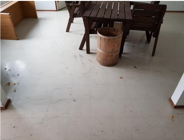
Kuvat 1 ja 2. Kerhotilan asbestipitoiset vinyylilaatat kiinnitetty asbestittomalla dispersioliimalla.
