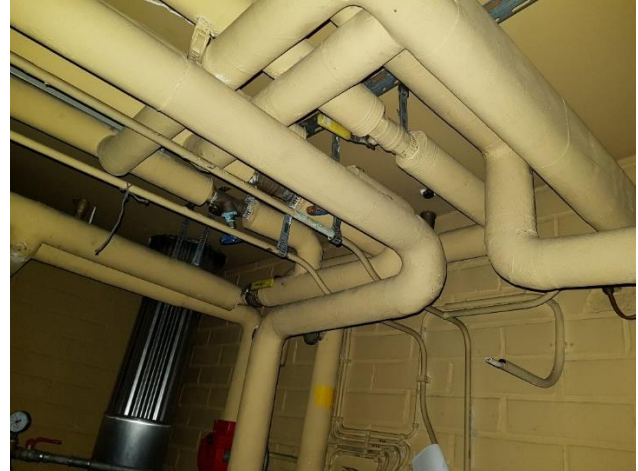
Kuvat 7 – 10. Lämmönjakuhuoneen putkieristeiden pintakangas sisältää asbestia.
